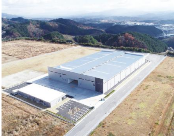
五條工場の全景。通路を挟んで2棟に連なり、破碎・選別の作業場、有価物・産業廃棄物の保管場など4区画に分けている
