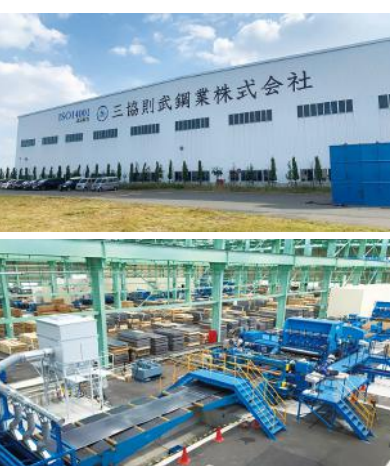
大型レバーが稼働する三協則武鋼業 (本社工場外観心構内)
