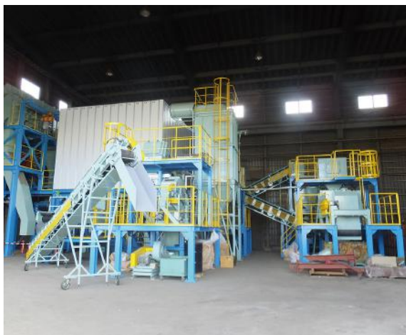
高度設備を配置した加工処理ライン
